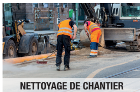
NETTOYAGE DE CHANTIER
